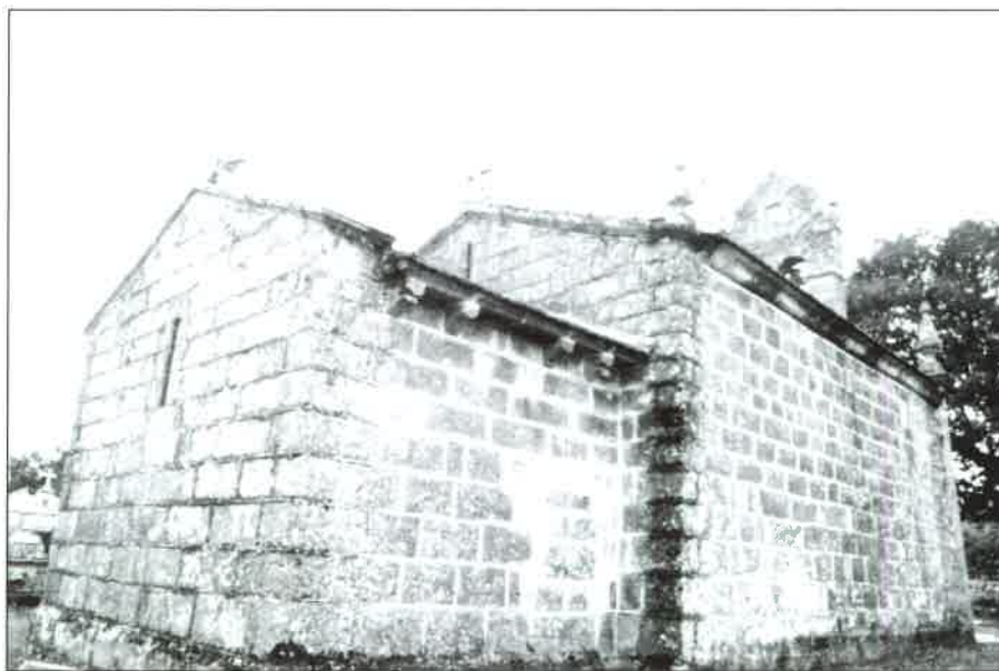
Fig. 2. Vista Norte de la Iglesia de Mandrás.
