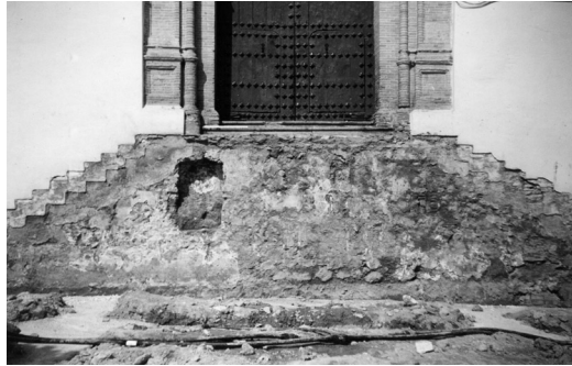
Restos de muralla en los cimientos de San Juan. Fotografía de Bartolomé Sánchez
