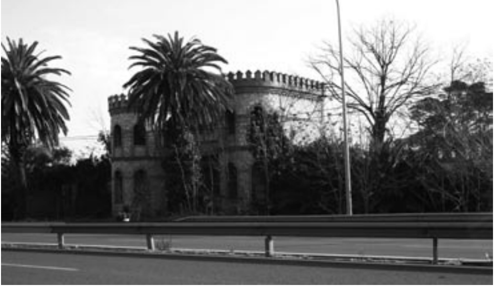
Pórtico de entrada al Campamento Benítez. Imagen actual.
