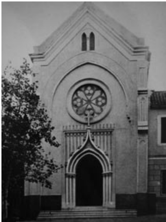
Fachada de la Capilla del Colegio de la Asunción. Archivo Temboury.
