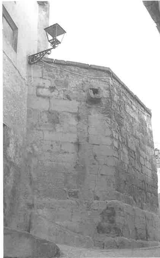
Fig. 33. Lienzo de muralla en la C/ Escolapios.
