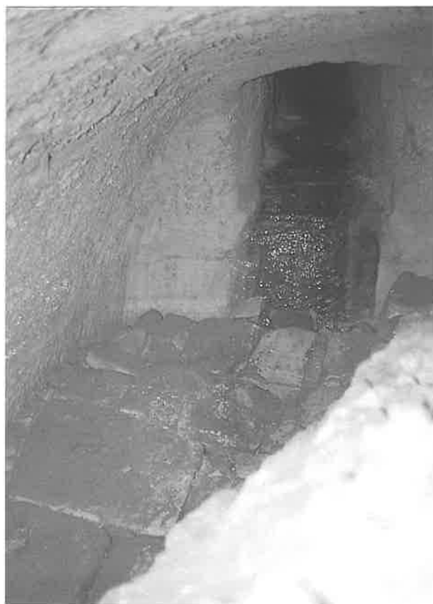
Fig. 40. Pasadizo bajo la plaza Mayor que comunica con el ayuntamiento.
