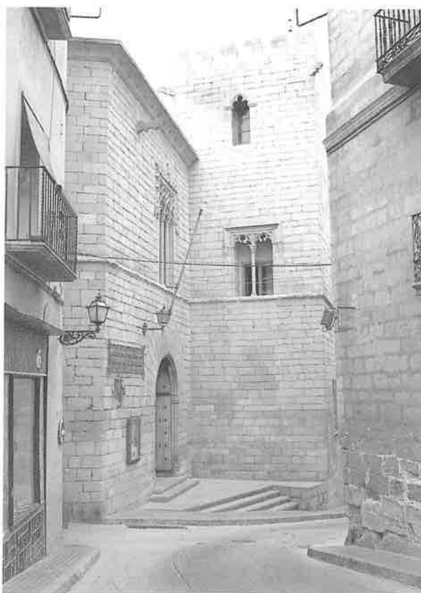
Fig. 26. Estado actual de la casa Ardid tras su restauración.
