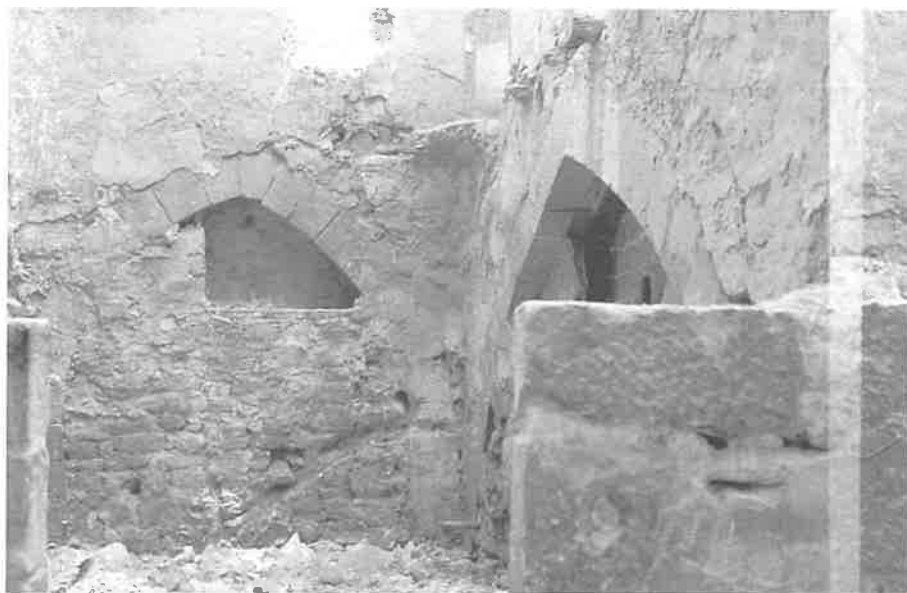
Fig. 38. Arcos apuntados en las medianerías de las plantas bajas del casco antiguo (callizo del Trinquete).
