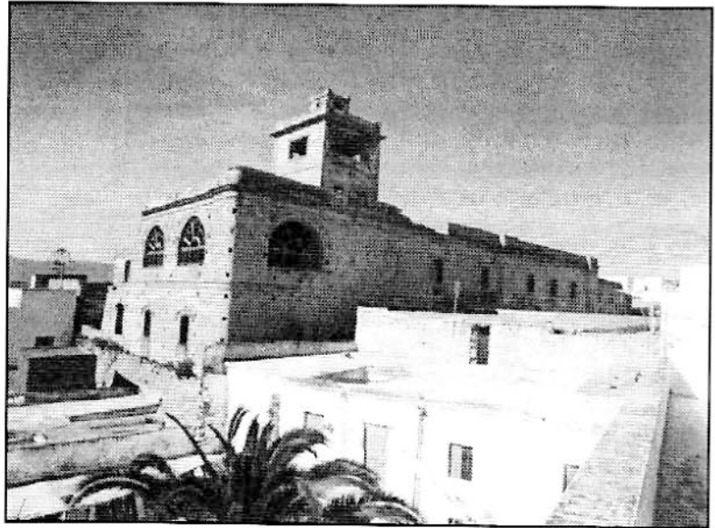
Fotografía del edificio conventual de extramuros según se encontraba antes de ser demolido en 1985. (Foto: Manuel Rojas). El edificio, con planta baja y dos pisos habría seguido en todo las líneas de los conventos alcantarinos, caracterizados por su sencillez y levantados en torno a un claustro con su patio y cisterna en el centro. Detrás del convento estaría la huerta.
