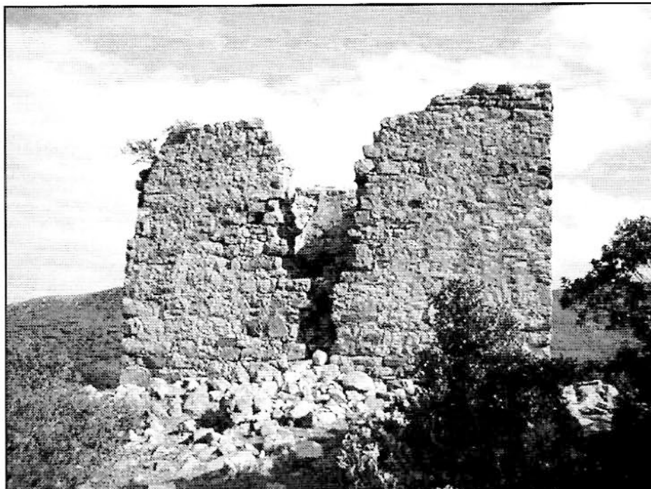
Parte posterior de la Torre del Rayo, en Puertollano, una de las torres del interior tarifeño olvidadas pronto como edificación de utilidad militar.
