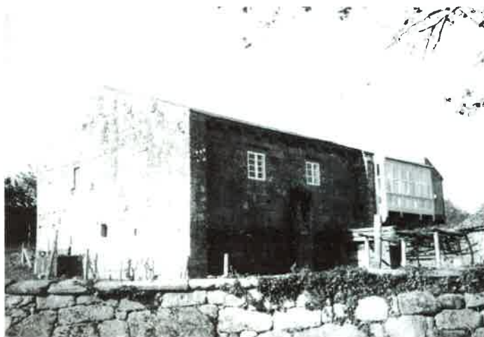
Fig. 1. Vista sur-oeste del edificio.
