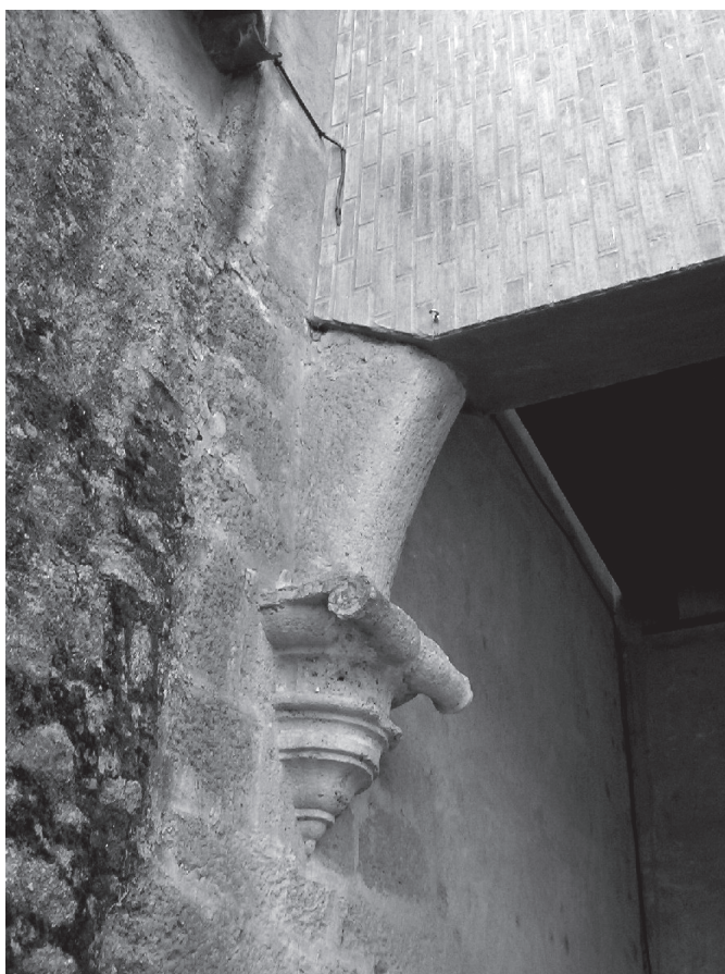
Fig. 6. Detalle de uno de los arranques de las arquerías que conformaban el patio renacentista del palacio, que apoyarían sobre columnas jónicas.
