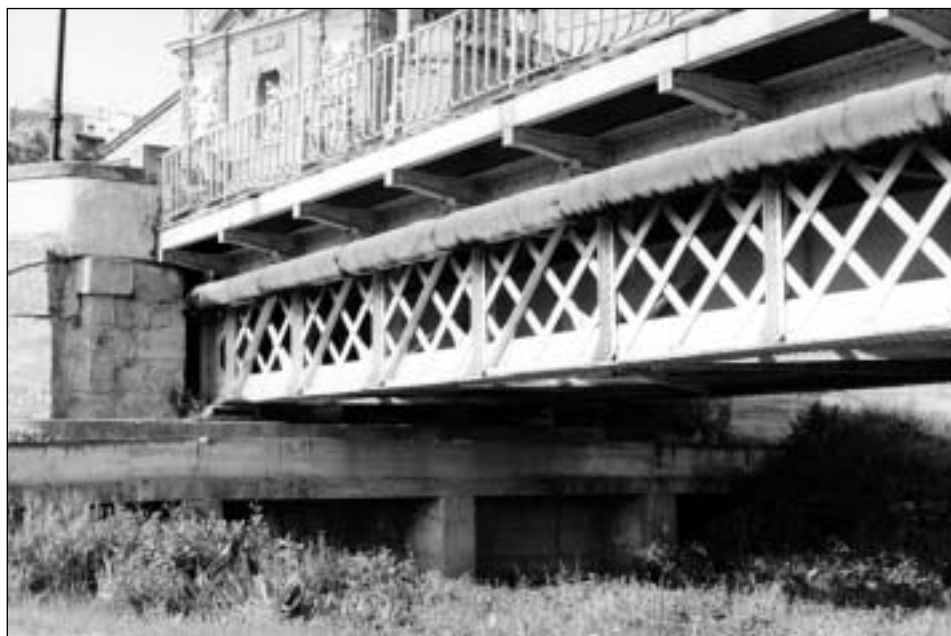
Figura 4.- Puente de hierro de Calahorra. Detalle.
