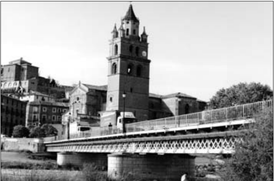
Figura 3.- Puente de hierro de Calahorra.
