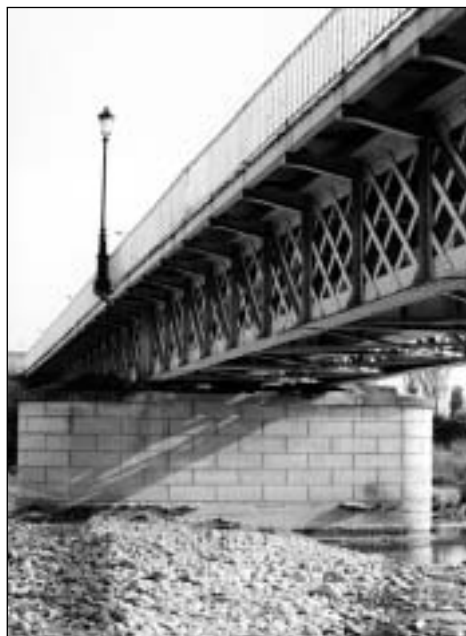
Figura 5.- Puente de hierro de Calahorra. Detalle.
