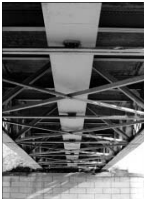
Figura 6.- Puente de hierro de Calahorra. Detalle.
