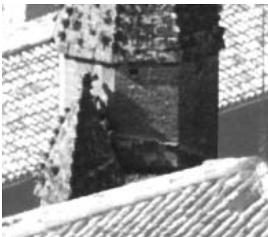
Foto 6. Se pueden apreciar todavía los retos del encuentro entre el nuevo tejado añadido con la torre de la escalera y el pináculo contiguo.
