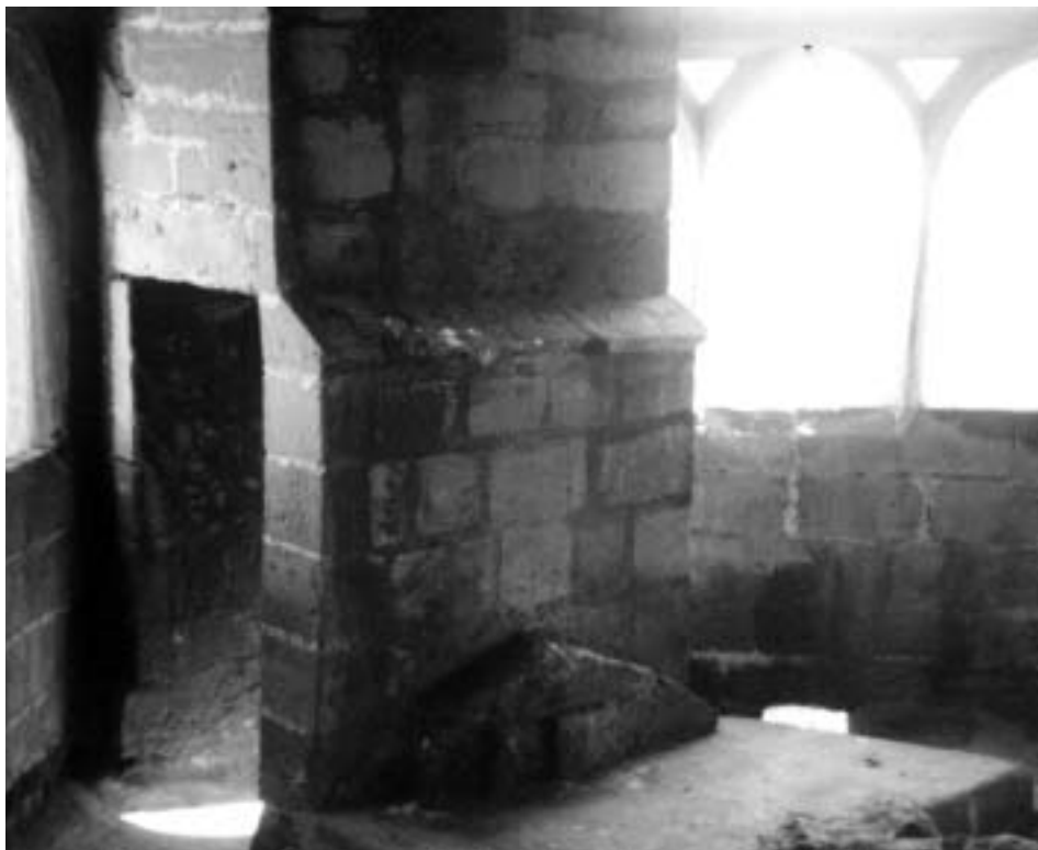
Foto 3. Parte superior, en la entrecubierta, del pináculo del ángulo noreste. Se puede apreciar cómo en la parte interior tiene la pequeña rampa que facilita el vertido del agua hacia el interior.
