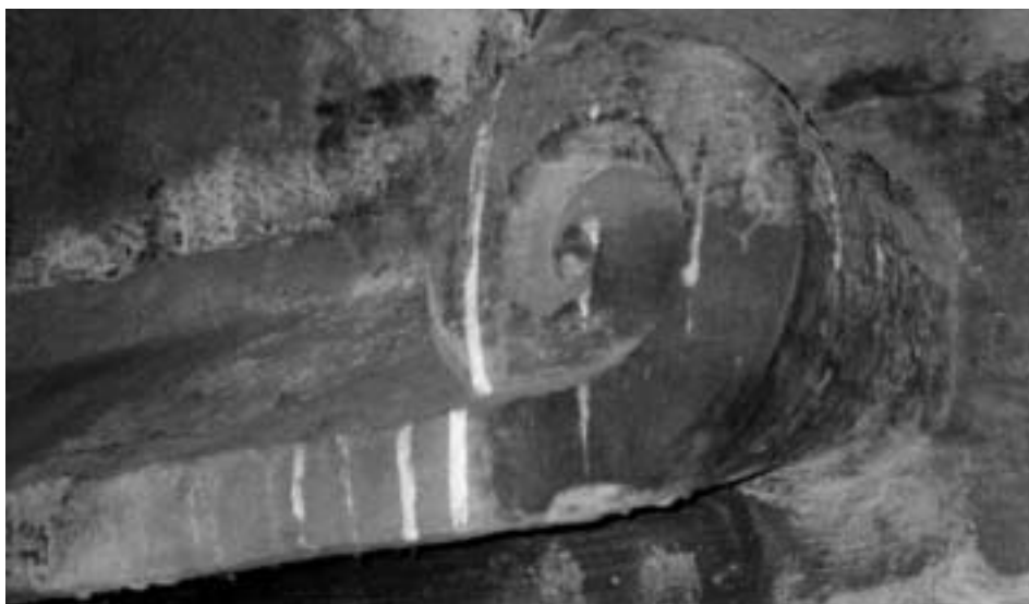
Foto 4. Voluta derecha en la marquesina sobre la puerta de acceso a la torre de caracol.
