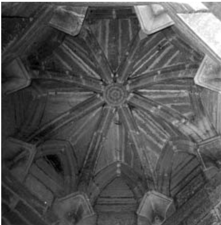
Foto 1. Bóveda octogonal con la que se cubre el interior de la torre de remate de la escalera.
