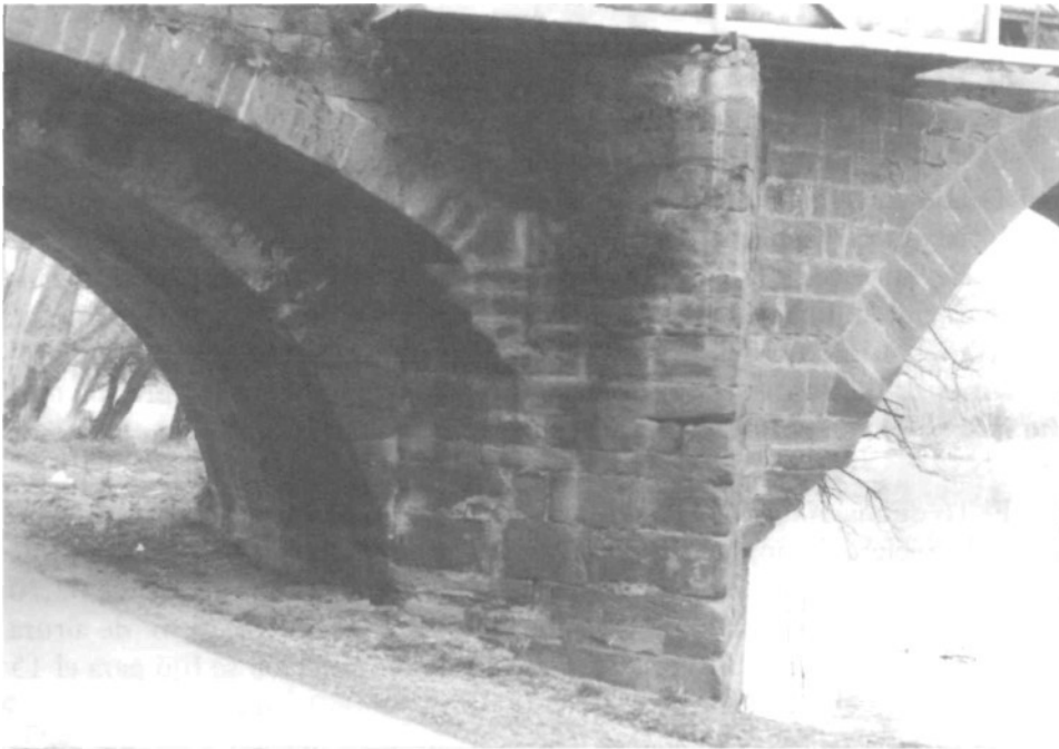
Detalle del puente.
