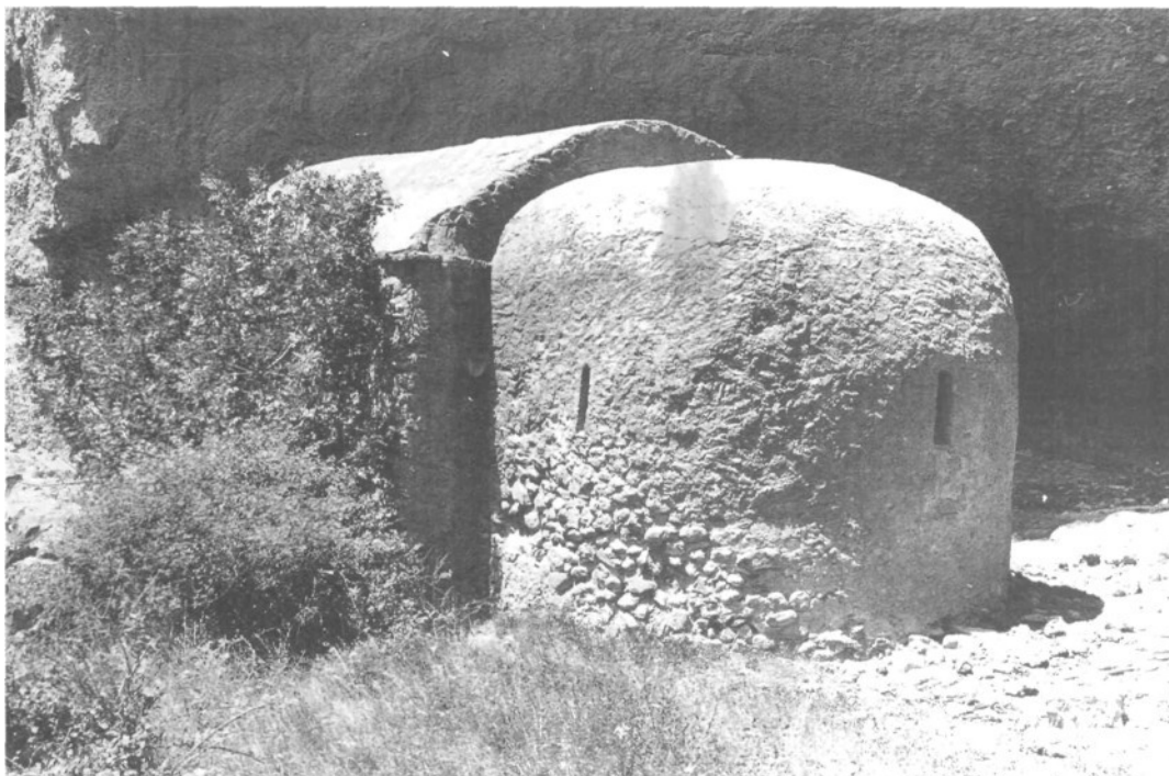
for. 2.-San Esteban. Exterior de la iglesia desde el sureste. La diferencia de materiales y paramentos denuncia las varias refacciones del templo.
