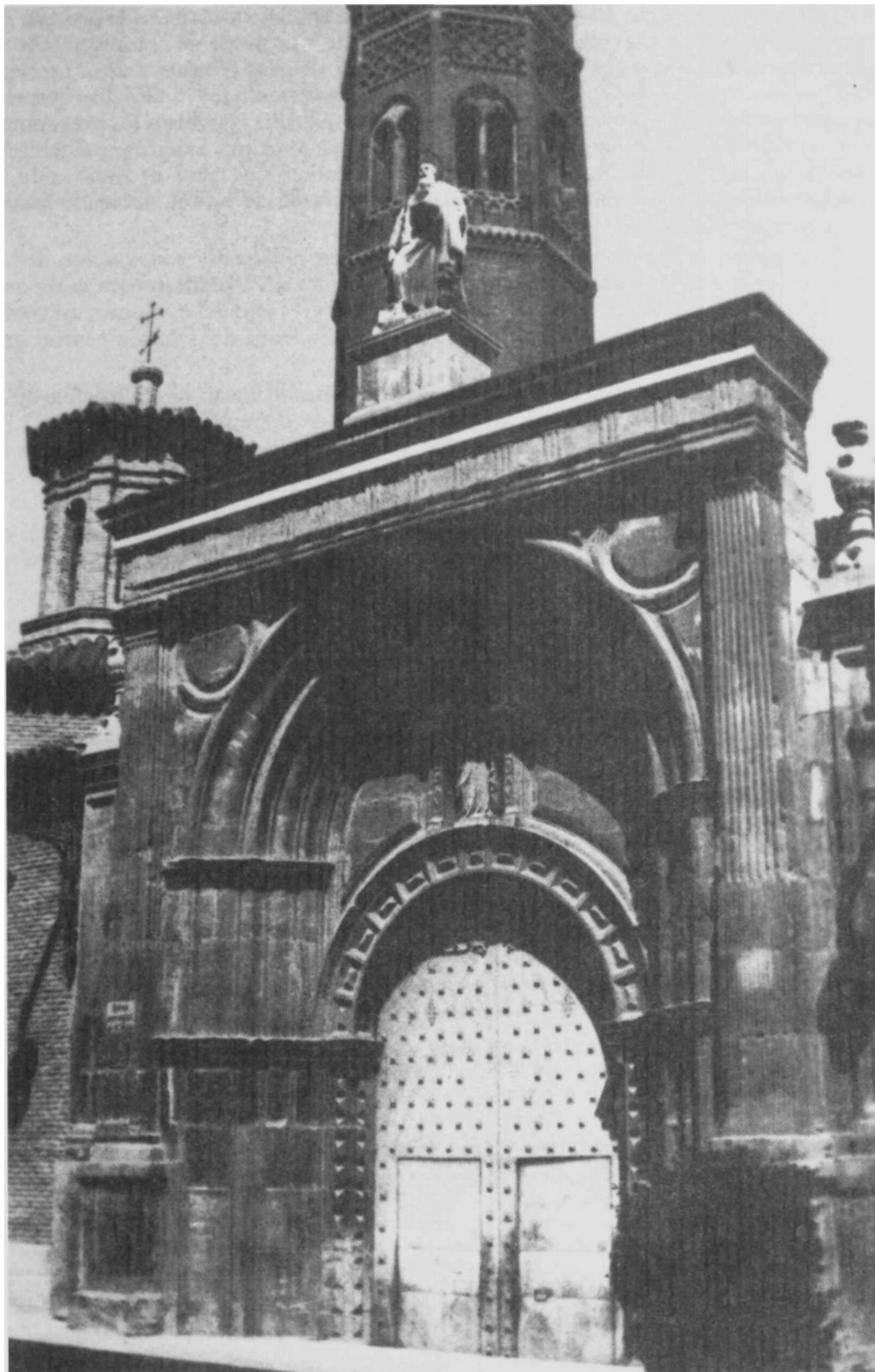
Fig. 2. Actual estado de la portada principal de la iglesia de San Pablo Apóstol de Zaragoza (Martín de Recondo y Juan de Villabona, 1593-1594) (Foto B. Boloqui).
