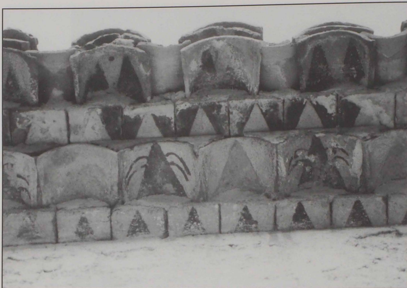
Tejas pintadas en el alero de una casa en Olocau del Rey
