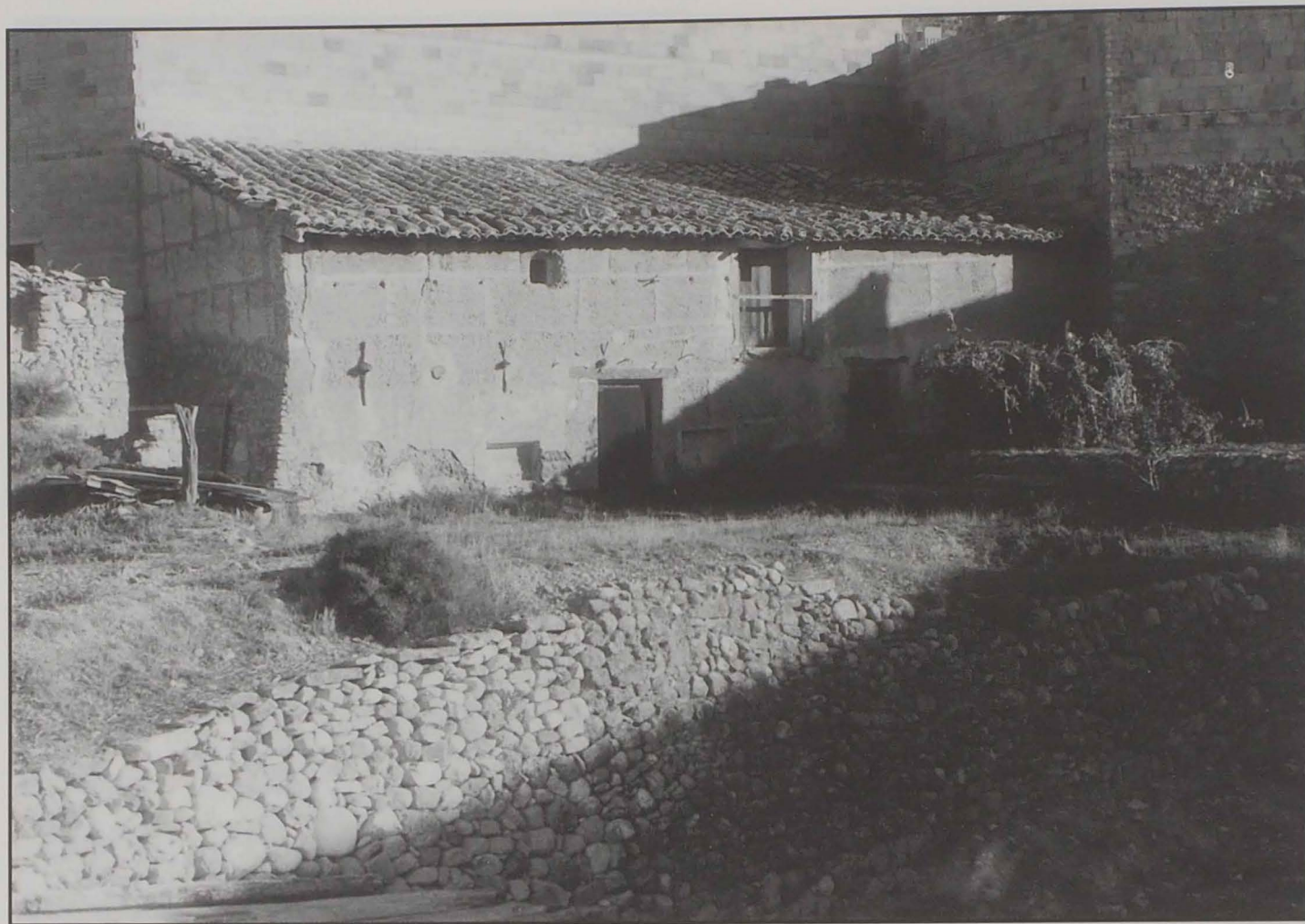
Alfarería Castel: obrador, horno grande (fondo izquierda) y balsa (por delante)
