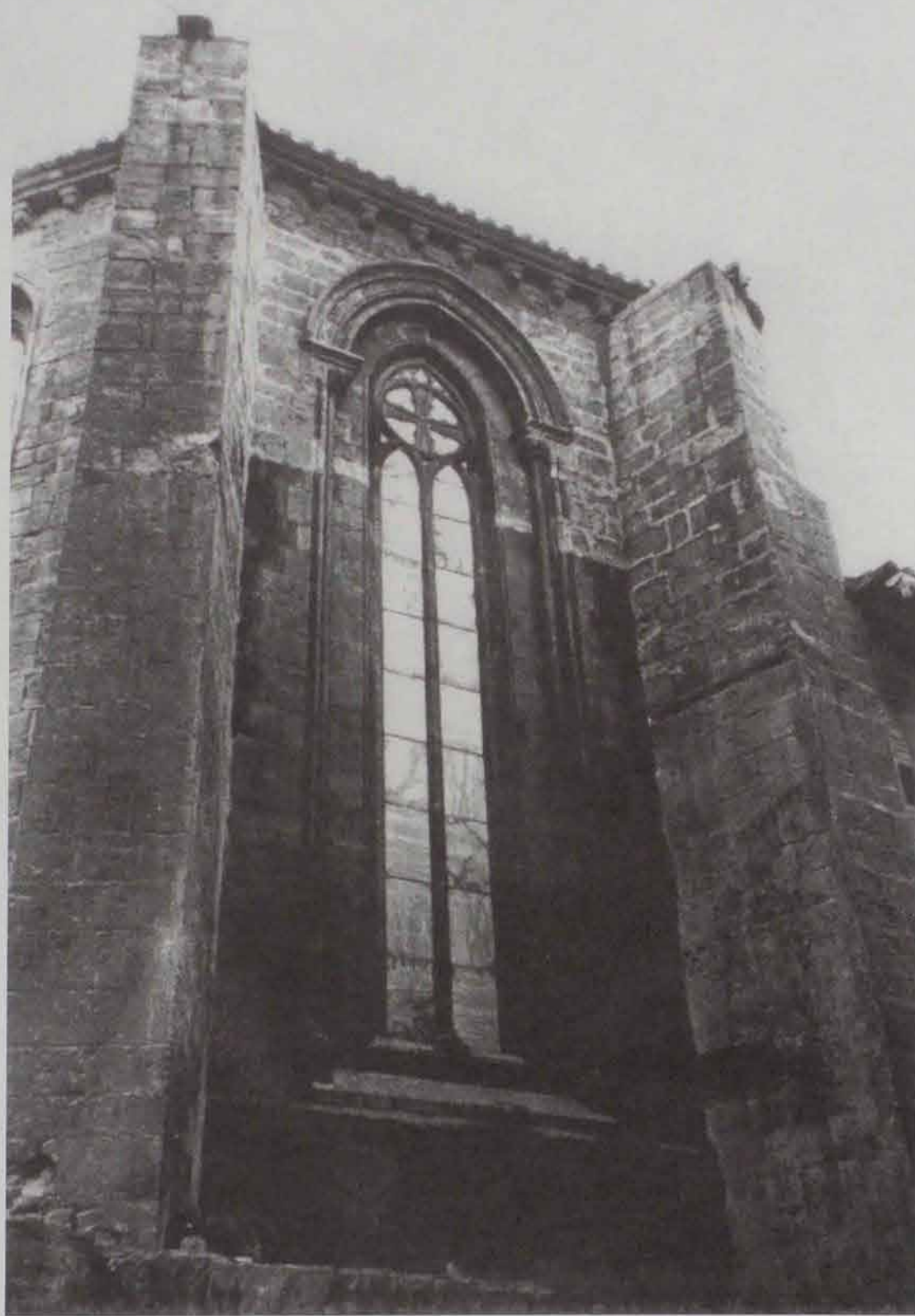
Figura 4. Vista exterior del ábside.
