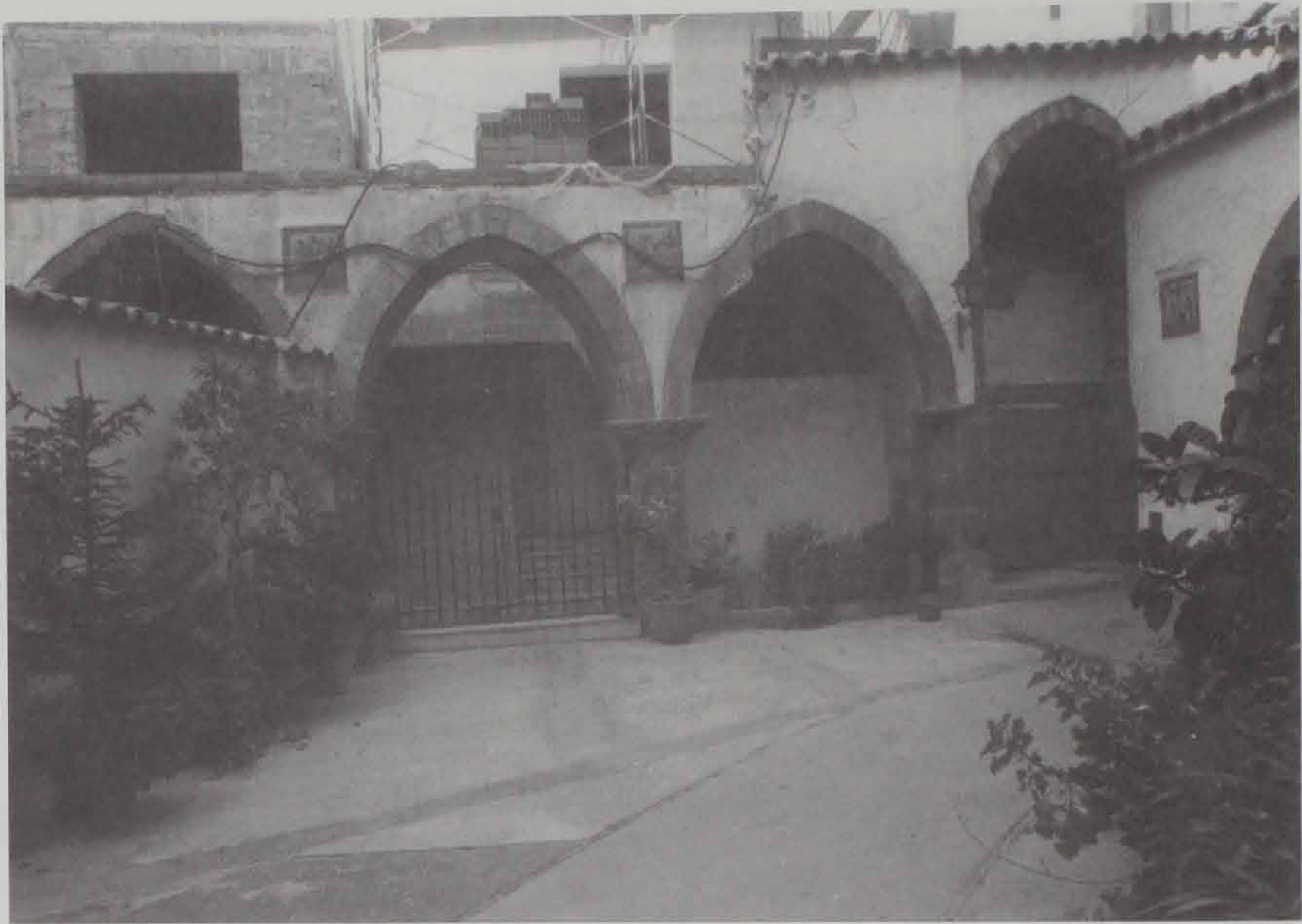
Figura nº 1.- Patio del Via Crucis. Arcada del antiguo claustro.
