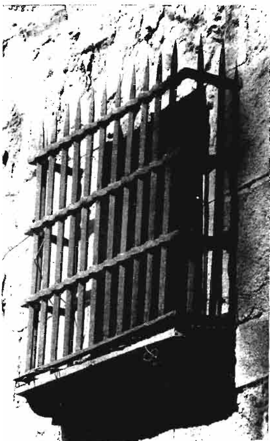
Foto 11.—Reja en una ventana de la casa-abadial "Apeztegi-zarre" (10 septiembre 1967).
