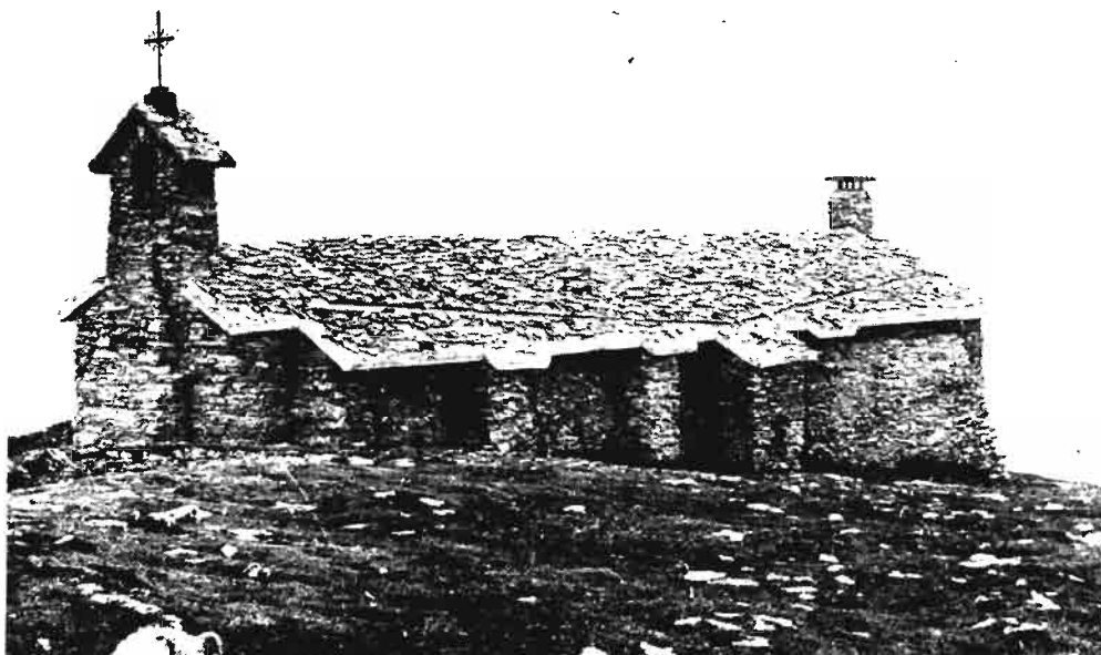
Ermita de San Donato y San Cayetano, de Huarte-Araquil. Masito fue el promotor, alma y financiador de su restauración, cuyas obras habrían de ocasionarle no pocos sinsabores. La ermita de San Donato arakildarra, frontera al santuario de San Miguel de Aralar de sus amores, se inauguraba, restaurada, el 14 de septiembre de 1958. Le dedicó un bonito artículo en la revista "PREGON", IRUÑAZALE (Nicolás Ardanaz) y otro en "El Pensamiento Navarro", Santi de Andía.
