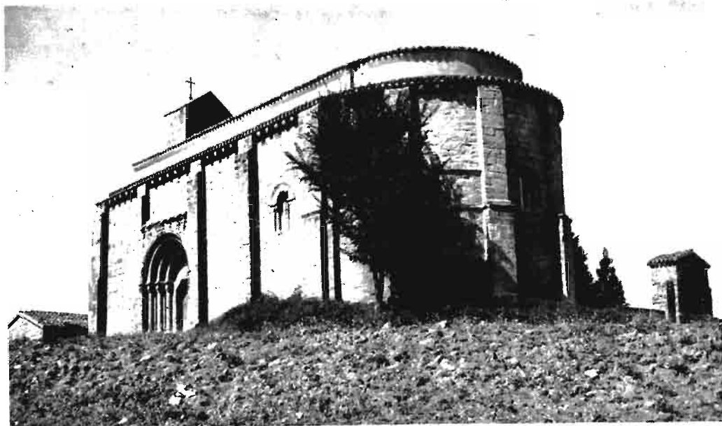
Núm. 28.—Santa María, de Badostain, en 1963, después de su restauración.
