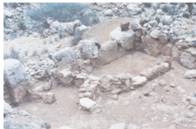
FIGURA 11: EVENTO 8 (ADITIVO): CONSTRUCCIÓN DEL MURETE 2. VISTA DEL MURETE 2 ASENTADO SOBRE EL MURETE 1 QUE CONFORMA EL RECINTO 401A.
