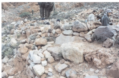
FIGURA 4: EVENTO 1 (ADITIVO/SUBTRACTIVO): CONSTRUCCIÓN DE LOS MUROS DE CONTENCIÓN DE LA TERRAZA DONDE POSTERIORMENTE ASENTARÁ LA UNIDAD 400 Y NIVELACIÓN DEL TERRENO. VISTA DE LOS MUROS DE CONTENCIÓN DE LA TERRAZA.
