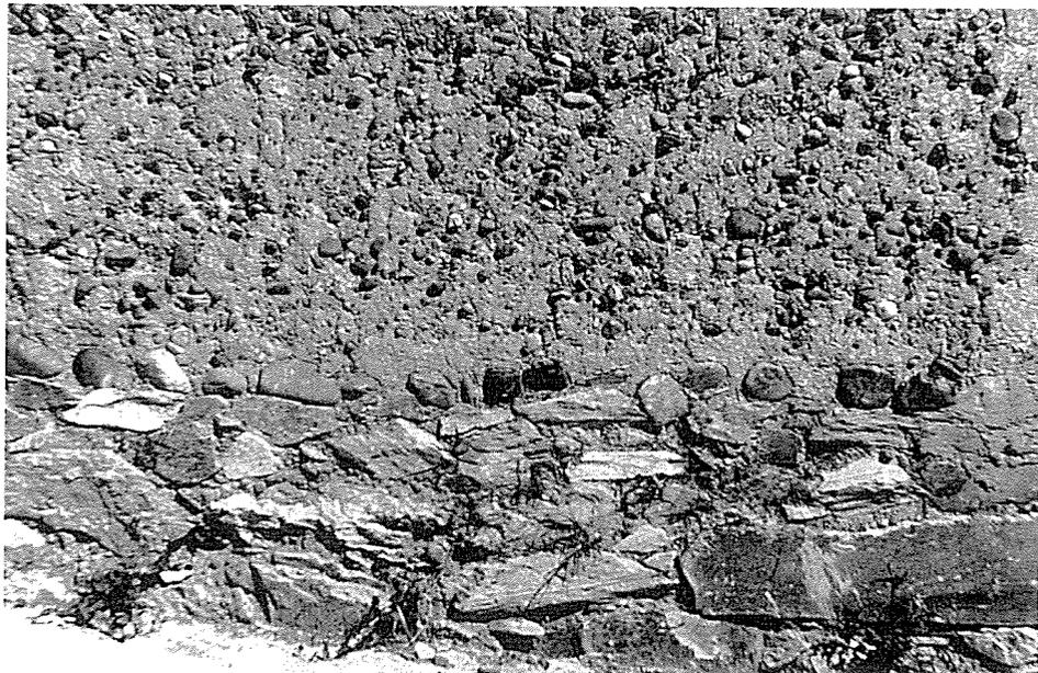
FIG. 3.- La tapia descansa sobre el alizar de lajas cuarcíticas. La pérdida del trullado permite apreciar la composición de la tapia. (Foto del autor)
