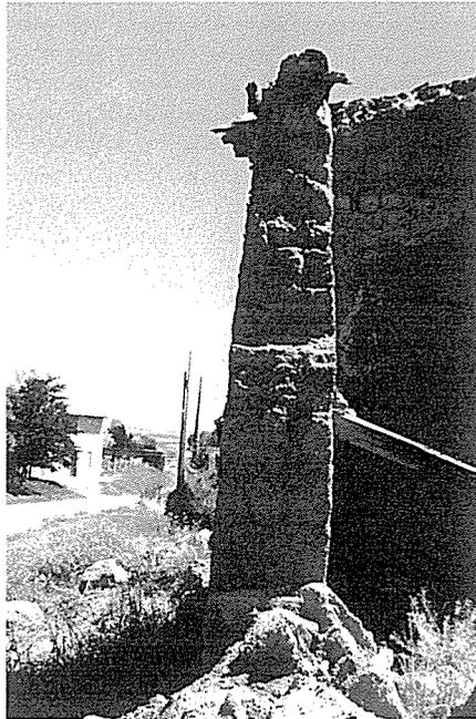
FIG. 2.- En la sección que nos ofrece esta ruina puede apreciarse el esviaje de los paramentos de un muro de fachada. Esta progresiva disminución del grueso de la tapia se conseguía mediante la disposición no paralela de las puertas de tapiar. (Foto del autor)
