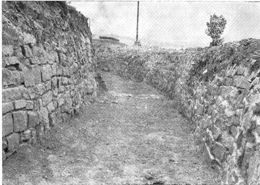
Lámina 6. Diversos aspectos de la canalización. Trazado y modo de ejecución.
