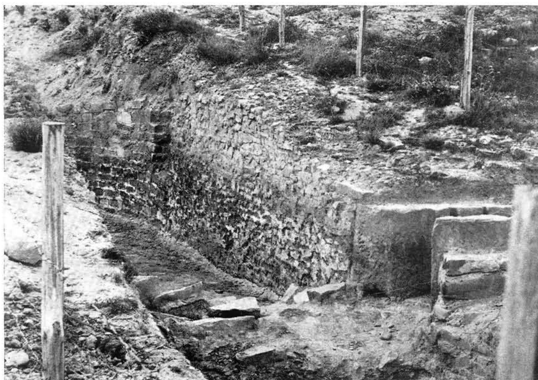
Lámina 5. Vistas de la canalización en la zona del aliviadero.
