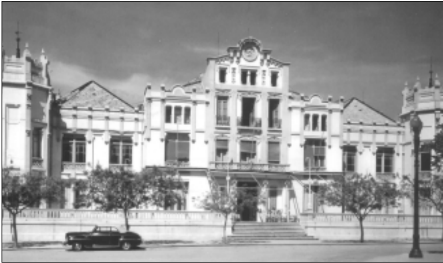
Foto 11. Círculo Oscense (Huesca), proyectado en 1901 por el arquitecto Ildefonso Bonells. Postal editada con motivo de su centenario.
