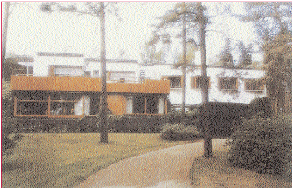
Alvar Aalto, Villa Mairea, vista xeral do volume exterior.
