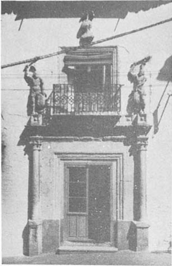
Fig. 15.- Antigua Casa de los Galianos. Alcaraz.
