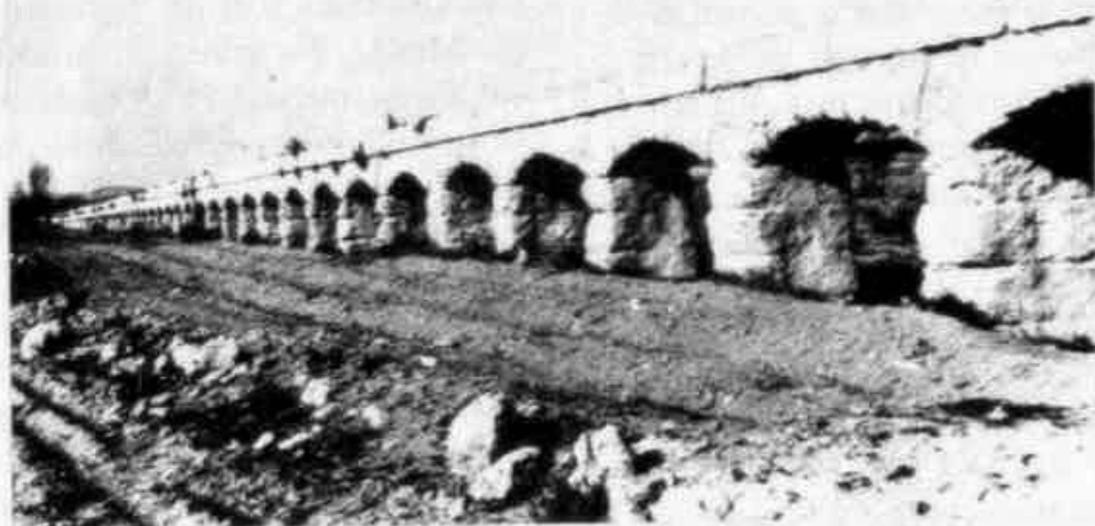
Vista parcial desde el lado Sur.
