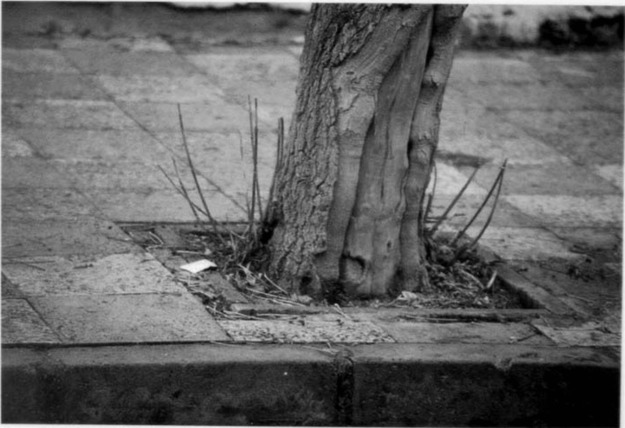
15. Alcorques insuficientes que frecuentemente aparecen en las calles de la ciudad.
