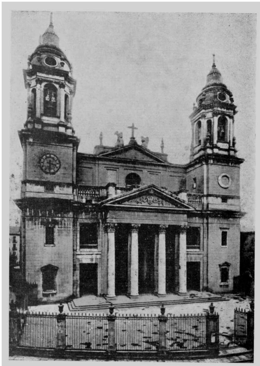
9.—Fachada actual de la Catedral de Pamplona
