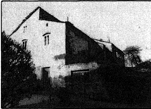
6. Vista de la fachada E.
