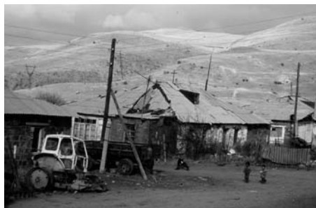
En Saravan (Vayots Dzor) el hábitat y el material agrícola están en un estado de fuerte deterioro. (Foto de la autora, tomada en 2000)
