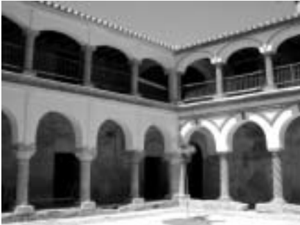
Claustro del convento de Santa Clara en proceso de restauración. Foto: Rafa Nieto.
