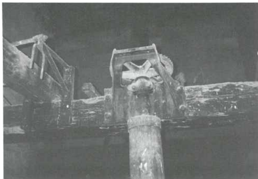
Foto núm. 31. —Parte superior del Palopedro y mecanismo de subida de la Torrecilla. Al fondo, 2 torrecillas; le falta el empiedro, pero conserva las 2 prensas, por sus torrecillas. Cortijo San Rafael, llamado La Molina. Villanueva de la Reina (Jaén).
