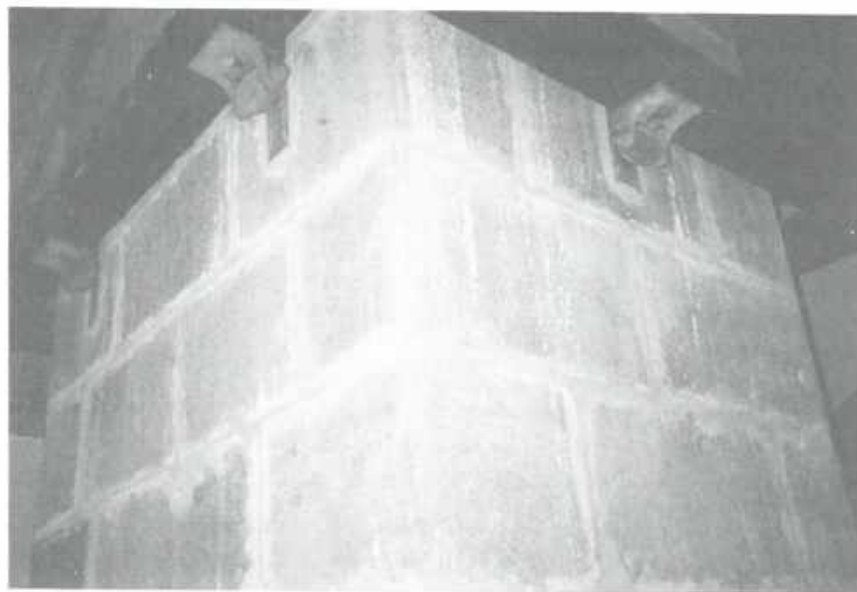
Foto núm. 12. —Guiaderas de la torre.
