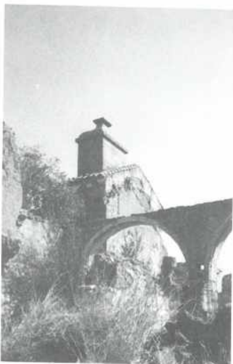
Foto núm. 33. —Torre de la derruida Hacienda Santa Amalia. Villanueva de la Reina (Jaén).
