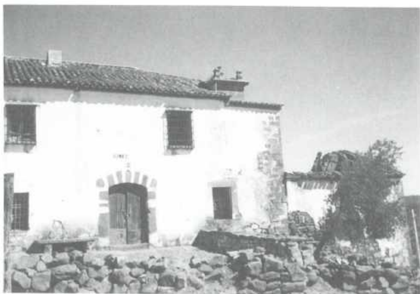
Foto núm. 36. —Torre de la Molina, situado en el Km. 54 de la carretera Montoro-Cardena.
