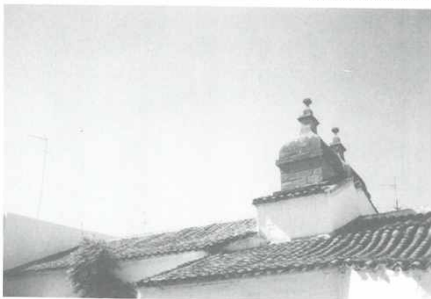
Foto núm. 34. —Dos torres pertenecientes al Molino de los Corchado, en la ciudad de Bailén. En su interior se conserva el Molino al completo, esperando su restauración.
