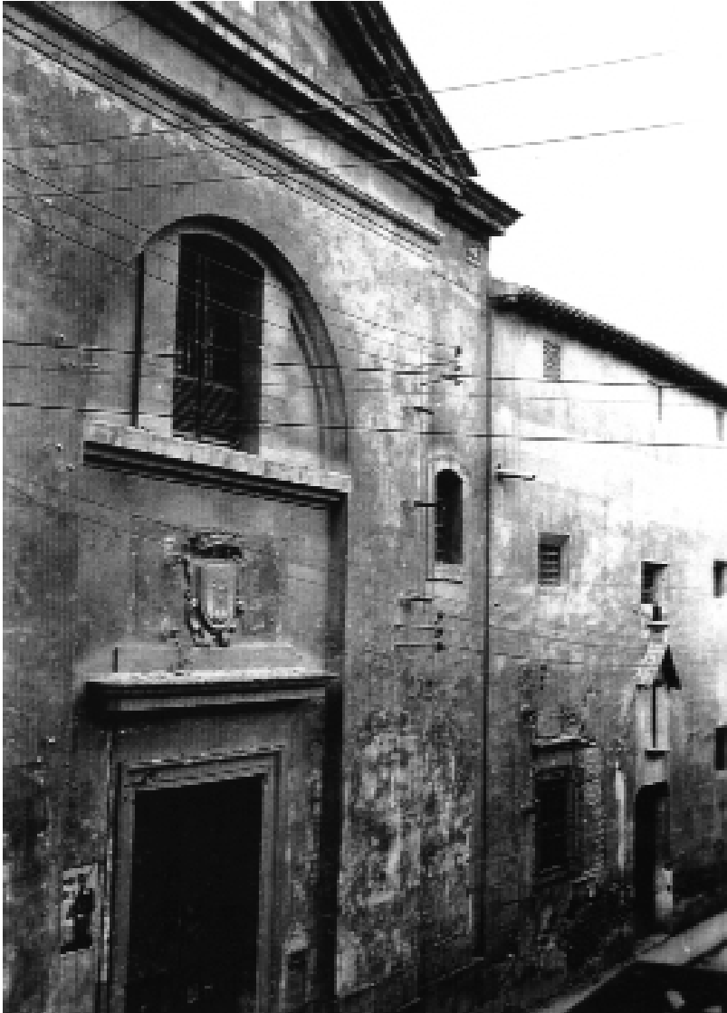
Fachada de la antigua iglesia del convento de Capuchinas de Murcia (fotografía cedida por D. Francisco Candel Crespo).
