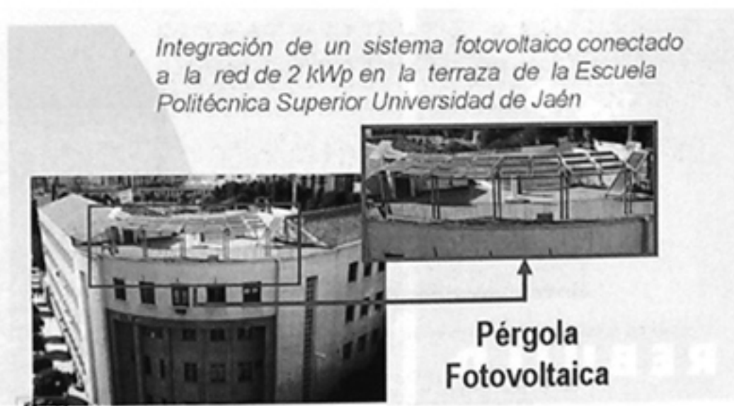
Figura 15.-Integración de la Pérgola fotovoltaica en el edificio de la Escuela Politécnica Superior de la Universidad de Jaén.
