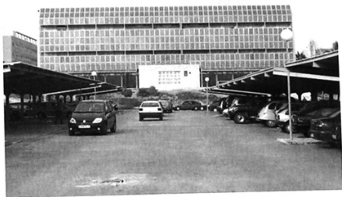
Figura 25. —Fachada paneles fotovoltaicos (Univer).
