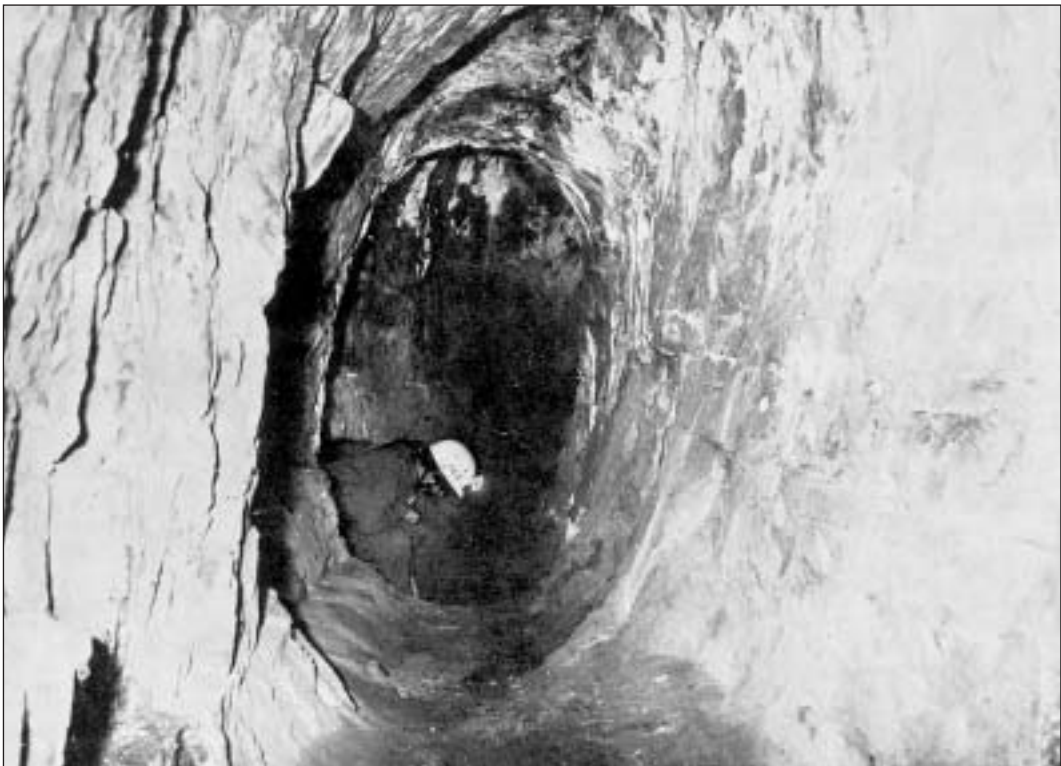
Lámina IV. Vista de la galería en la que se puede apreciar su forma ovoide y sus dimensiones
