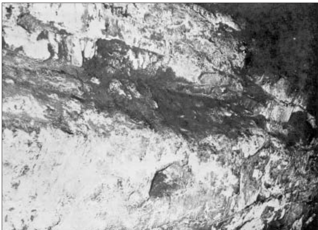
Lámina VII. Pared lateral con huellas del entibado
