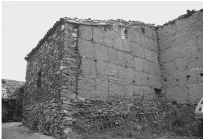
FIG. 6. La piedra y la tierra: mampostería y tapial (Berzocana).
