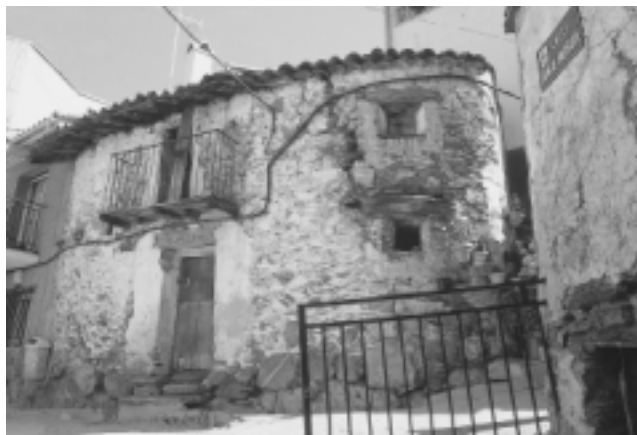
FIG. 1. Vivienda tradicional con balcón (Navezuelas).
