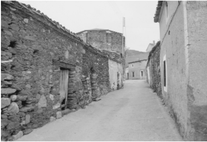
FIG. 11. La desnudez de los paramentos nos deja ver su interior (Retamosa).
