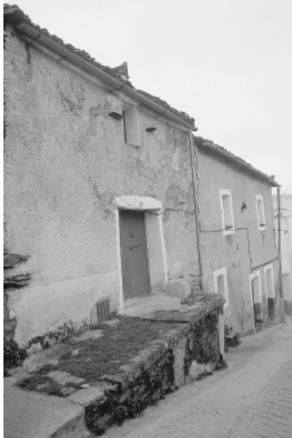
FIG. 14. Viviendas entramadas de Guadalupe fuera del recorrido turístico (Guadalupe).
