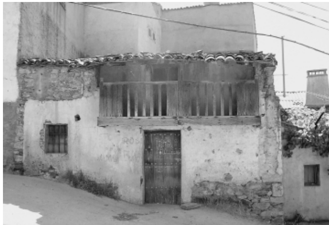
FIG. 10. Uno de los pocos ejemplos de solana corrida sobresaliente en la comarca (Roturas).
