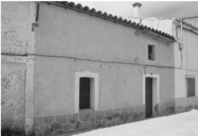
FIG. 13. Vivienda transformada y enfoscada para adecuarse a los nuevos tiempos (Solana).
