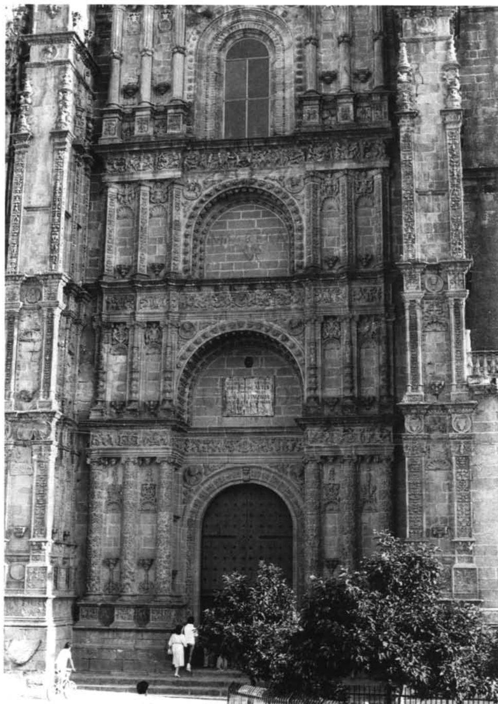
FIG. 1. Fachada norte de la catedral de Plasencia.
