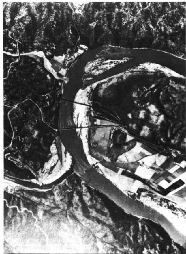
Figura 3. Fotografía aérea del río Tago en Alconétar, con los restos del puente romano, el puente de 1928, y el del ferrocarril de 1933.
