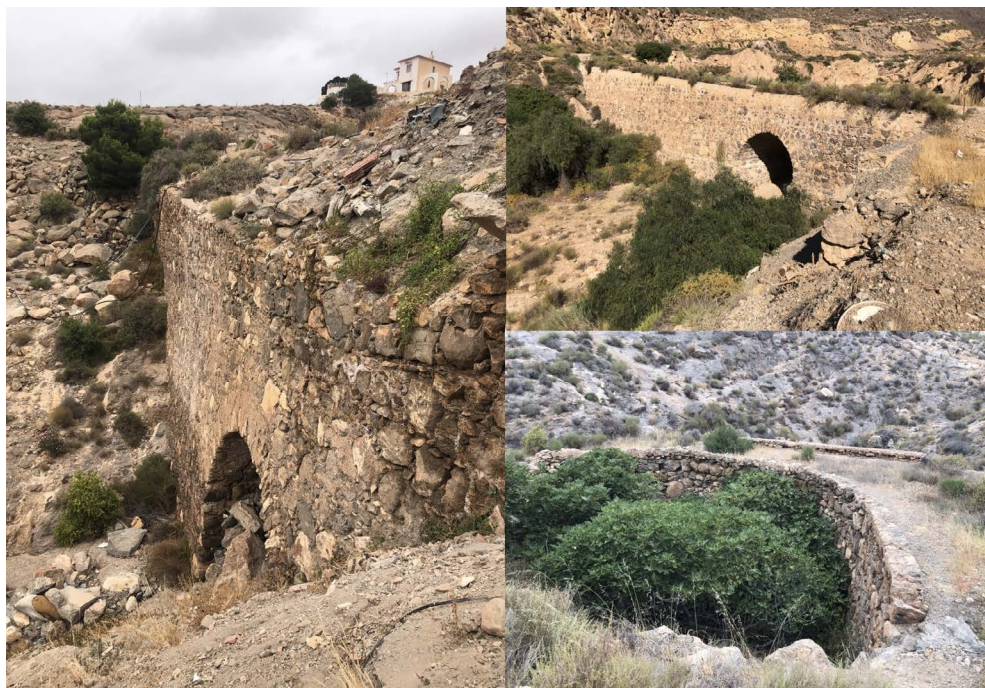
Figura 9. Tres de los puentes que jalonan el camino y no están catalogados ni publicados. A la izquierda puente Chequio, arriba puente del Campo y abajo derecha Puente Ramón.
