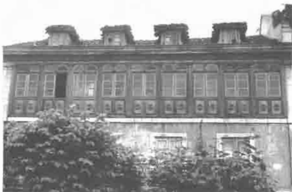
Lám. 14.—Plaza del Marqués de Muros, n.º 3. Galería historicista, fines del XIX.
