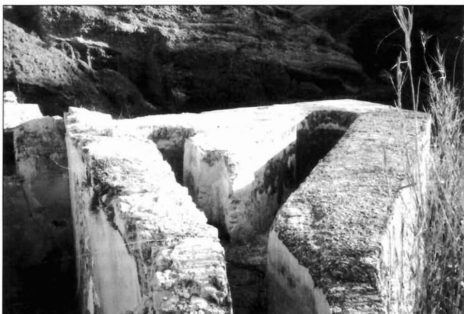
FOTO 2. Molino del Chícamo. Un ejemplo de molino con doble cubo en la Región de Murcia.
