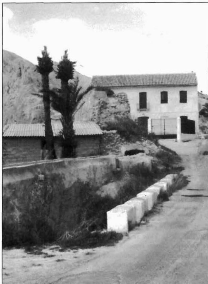
Foto 4. Panorámica donde se observan los restos del viejo y del nuevo Molino del Arco.
