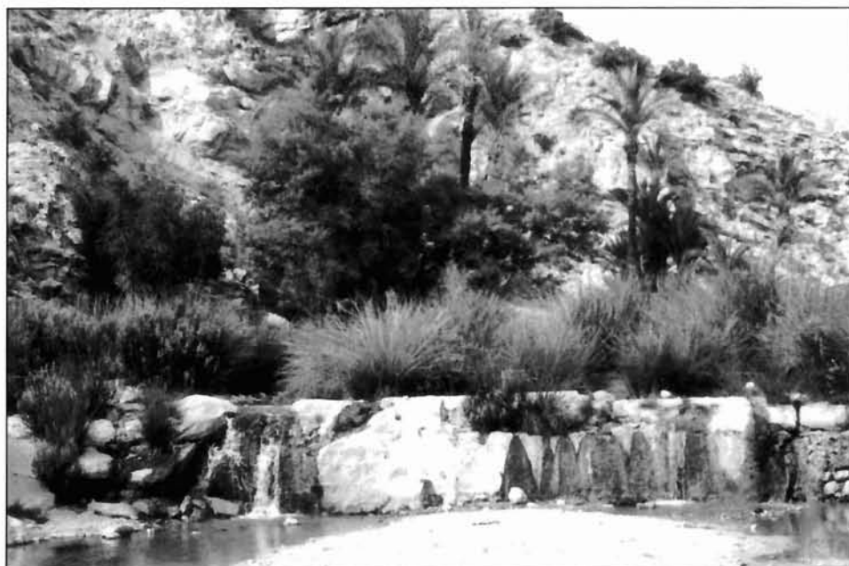
FOTO 1. Presa o azud en la cabecera del río Chícamo de donde se derivaba el agua al molino.
