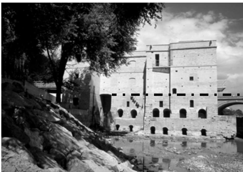
FIGURA 3. Lateral del Molino. La línea separa la parte medieval y renacentista con sus muros de sillería de la moderna (s. XX) de ladrillo.
