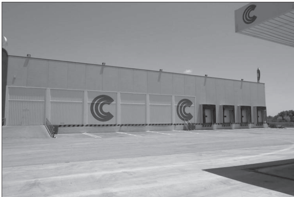
FOTO 8. Instalaciones del Grupo Caliche en El Mirador-San Javier (Murcia). Más de 10.000 m 2 destinados a la logística y al transporte.
