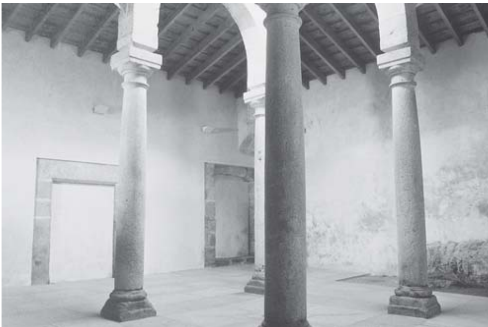
FIG. 8. Interior. Detalle de las puertas del vestíbulo y la sala de oración de las mujeres.
