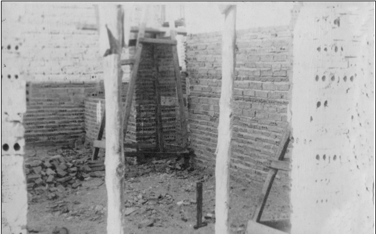
Aspecto de las obras de construcción del templo del Gran Poder.
