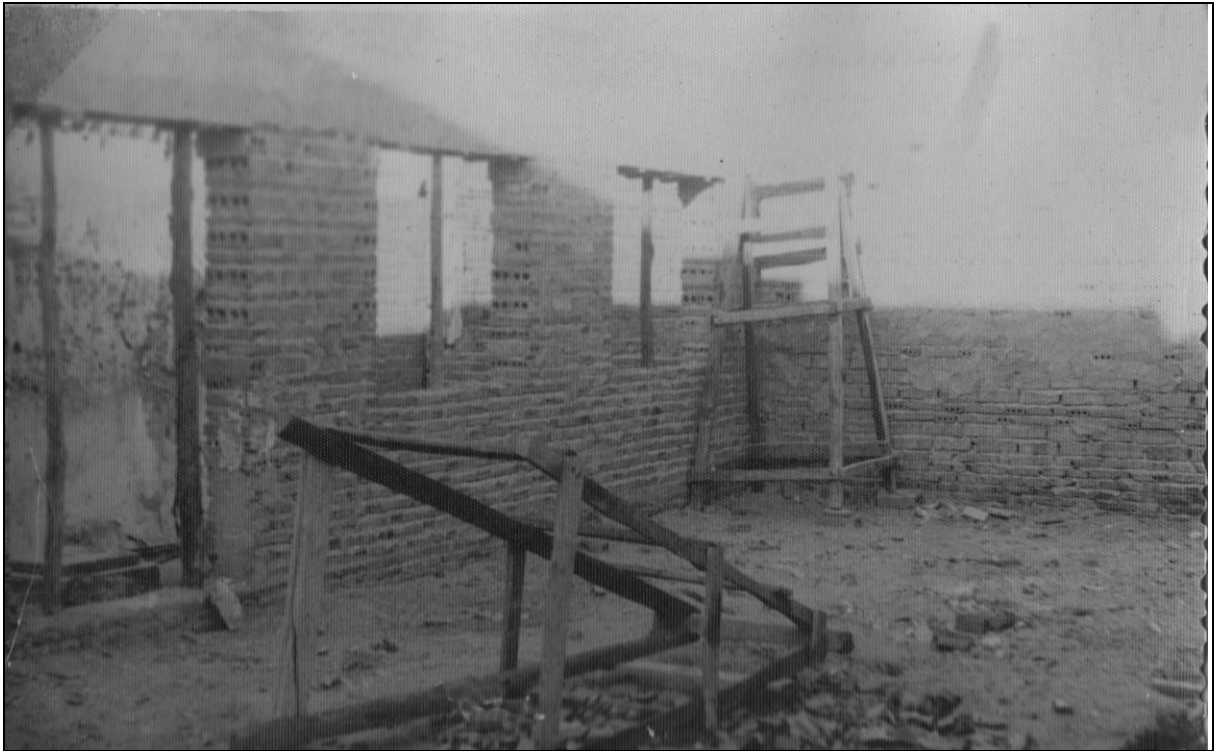
La foto recoge un instante de las obras del Gran Poder.
