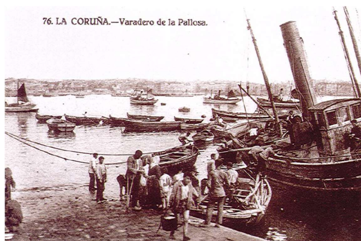
Figura 32: Varadero del Muelle de A Palloza, 1930. Archivo Municipal de A Coruña.
