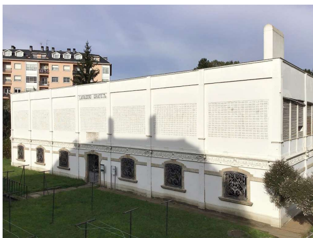
Figura 43: Vista exterior del lavadero público de As Cascas (Betanzos, A Coruña). Consultada en [16].
