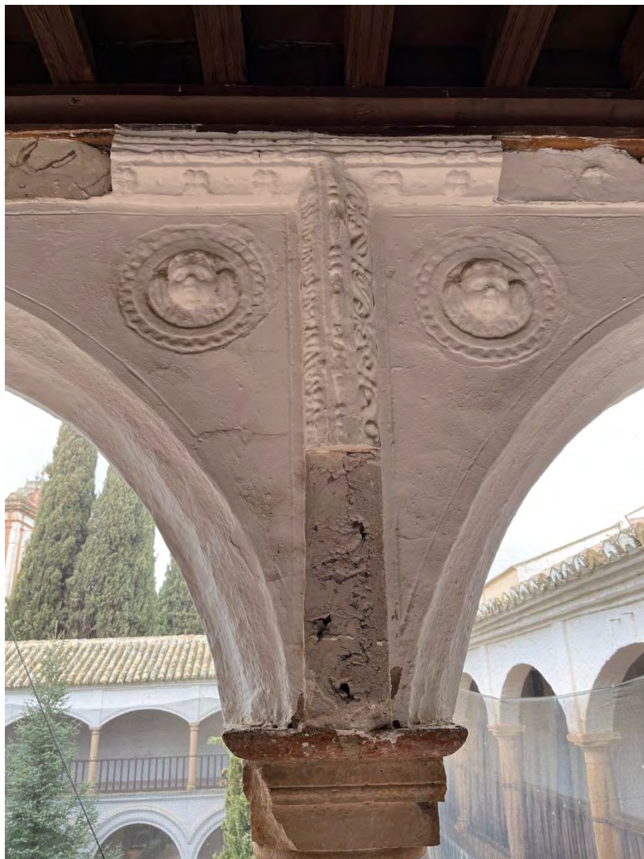
Fig. 12. Detalle de la decoración clasicista de las enjutas de los arcos. Claustro del convento de Madre de Dios
