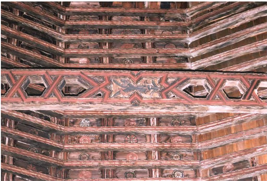
Fig. 6. Armadura mudéjar que cubre la nave central de la iglesia de Santo Domingo
