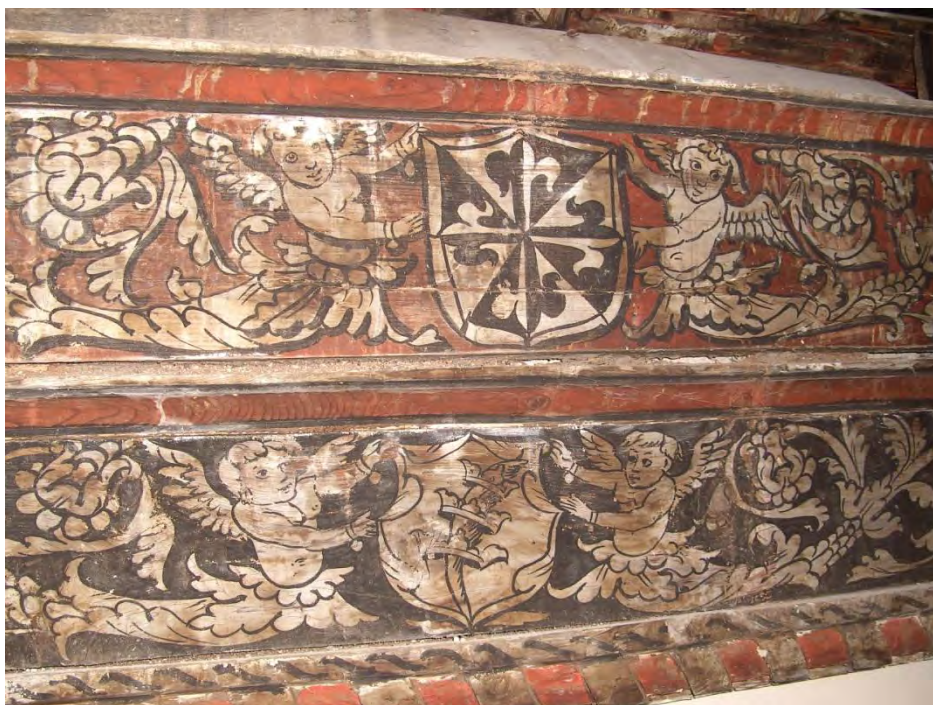
Fig. 7. Detalle de la decoración de la armadura mudéjar de la iglesia de Santo Domingo
