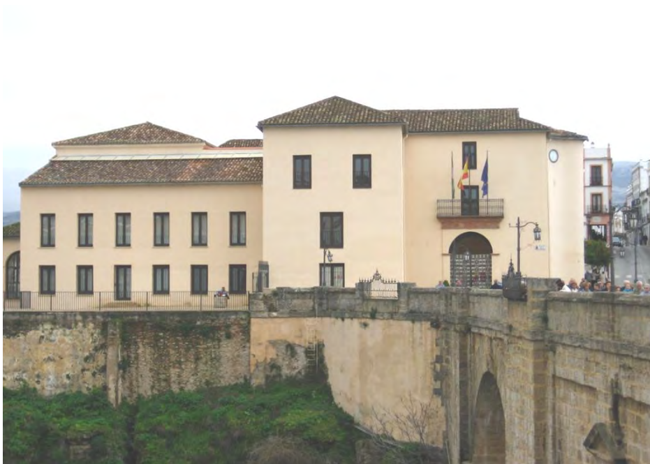
Fig. 1. Vista del antiguo convento de Santo Domingo junto al célebre Puente Nuevo de Ronda
