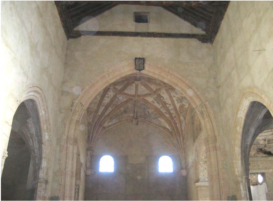
Fig. 5. Nave central y capilla mayor de la iglesia de Santo Domingo
