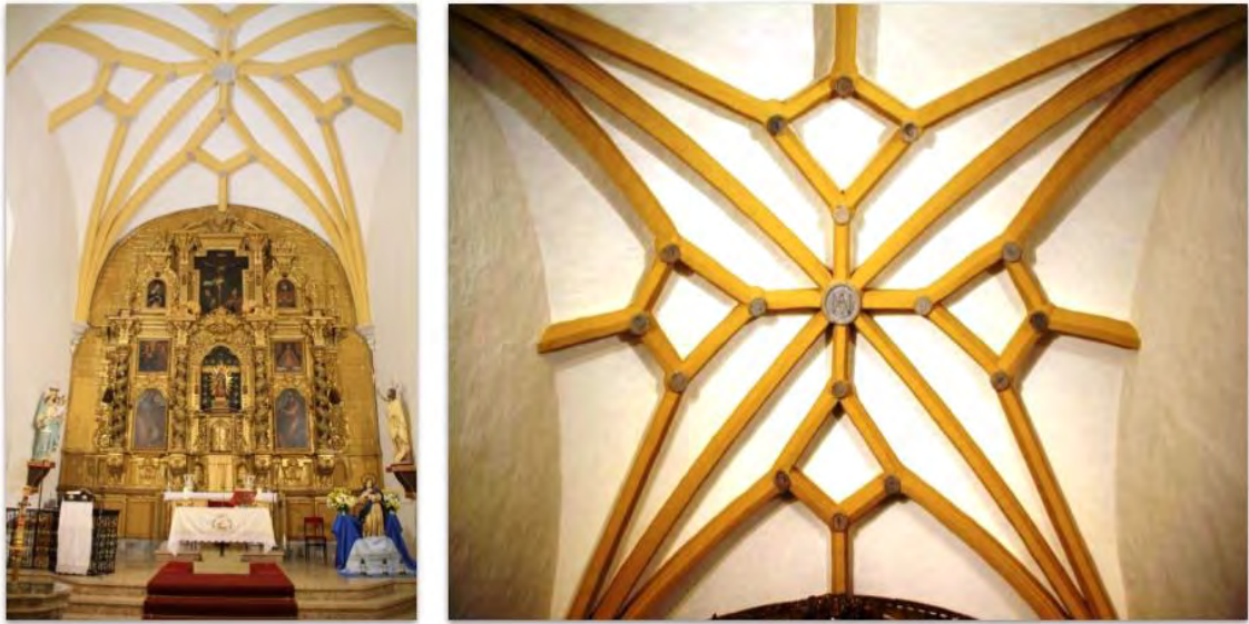
Figura 10. Cabecera con el retablo mayor y la bóveda de crucería con las claves.
