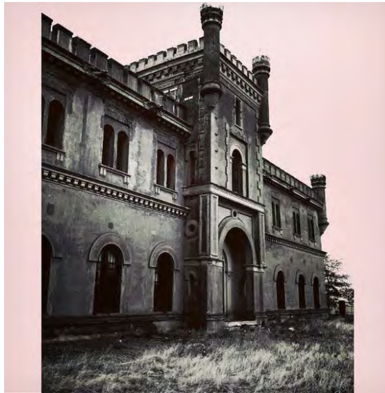
Ilustración 8: Fachada del Sanatorio (fotografía realizada por Francisco Javier Ginés Gil, año 2018).
