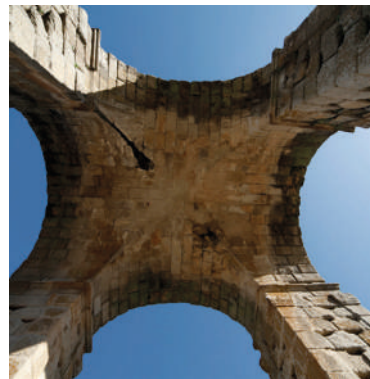
Fig. 6. Detalle de la bóveda del tetrapylon en la actualidad (M. Gómez).
