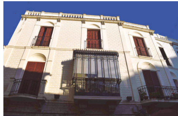
Fig.9. Vivienda en calle del Sol nº 28 (30 actual). Plasencia (Cáceres) (¿1885?): Detalle. Fotografía de M. Hurtado.
