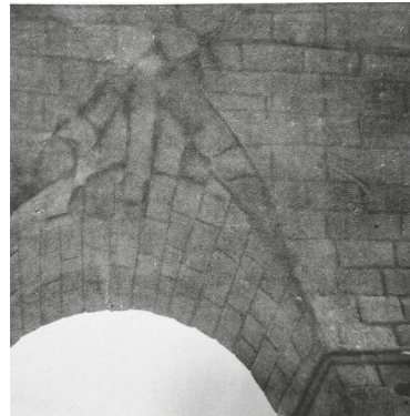
Fig. 5. Detalle de la bóveda del tetrapylon , de Mérida, (CMCÁC, III, 42, foto Prieto).
