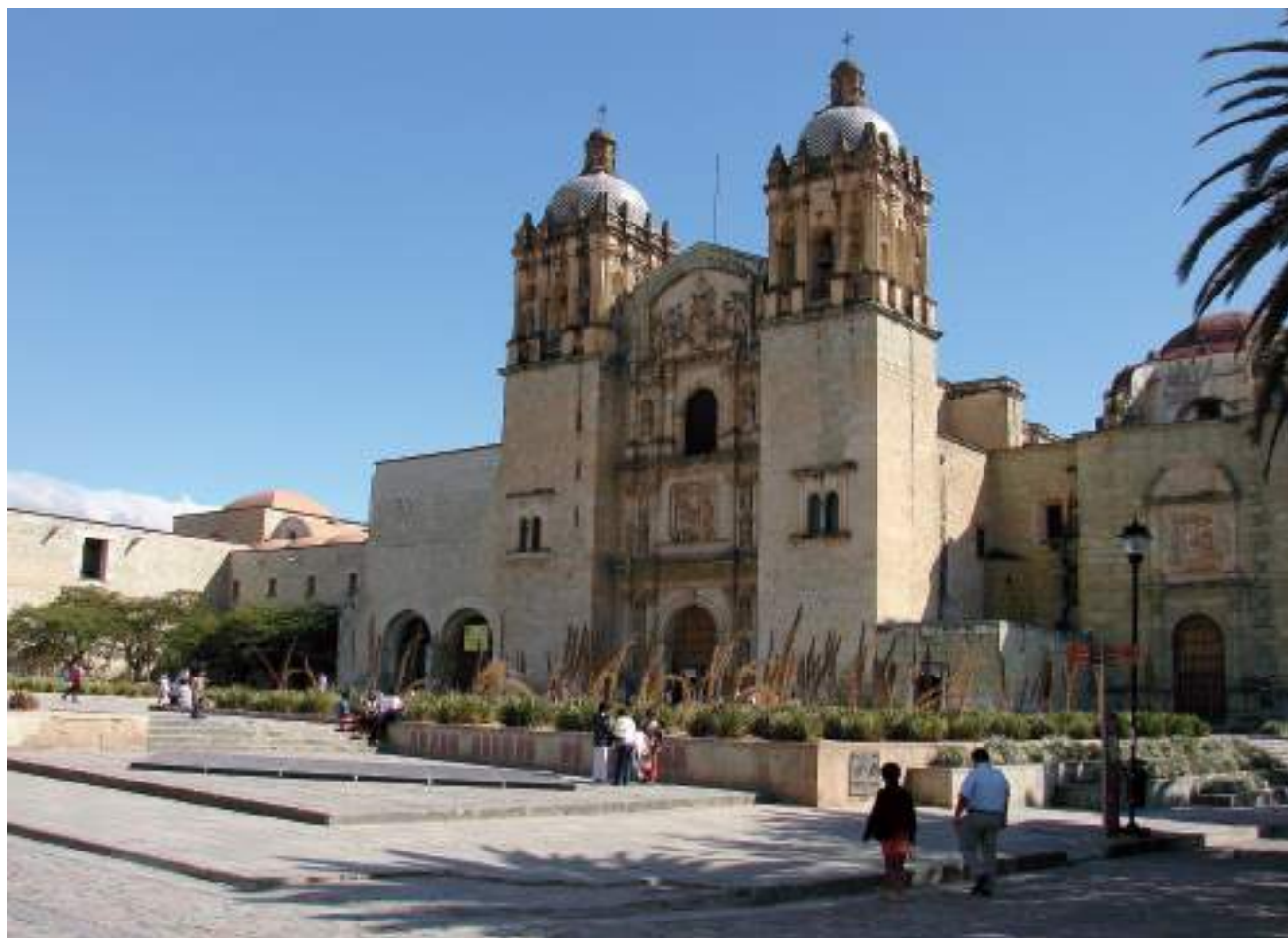
Fachada principal de la iglesia del convento de Santo Domingo de Oaxaca (México), cuyo promotor fue Fray Bernardo de Alburquerque. Siglo XVI
