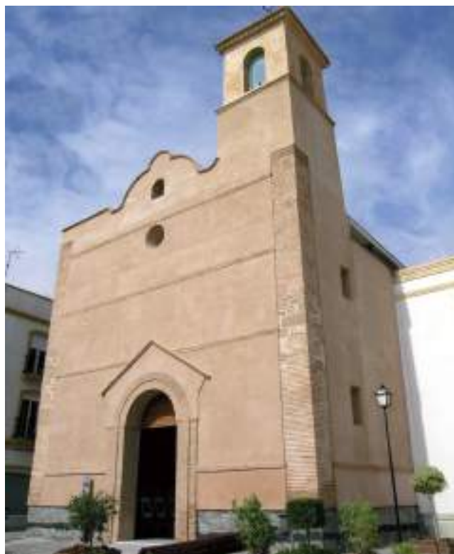
Fachada exterior del convento de los Padres Mínimos de Vera, recientemente restaurado como equipamiento cultural
