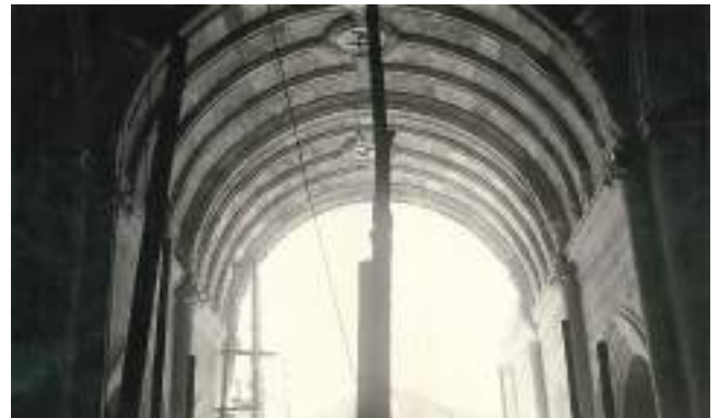
Reposición de la bóveda de la nave central del templo
