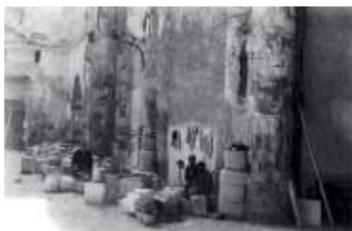
Operarios en los trabajos de reconstrucción de la iglesia de Santo Domingo
