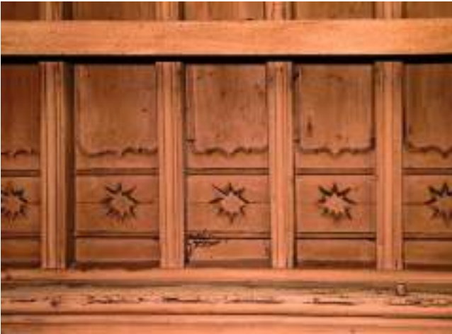
Chellas y alfarzones de la armadura
