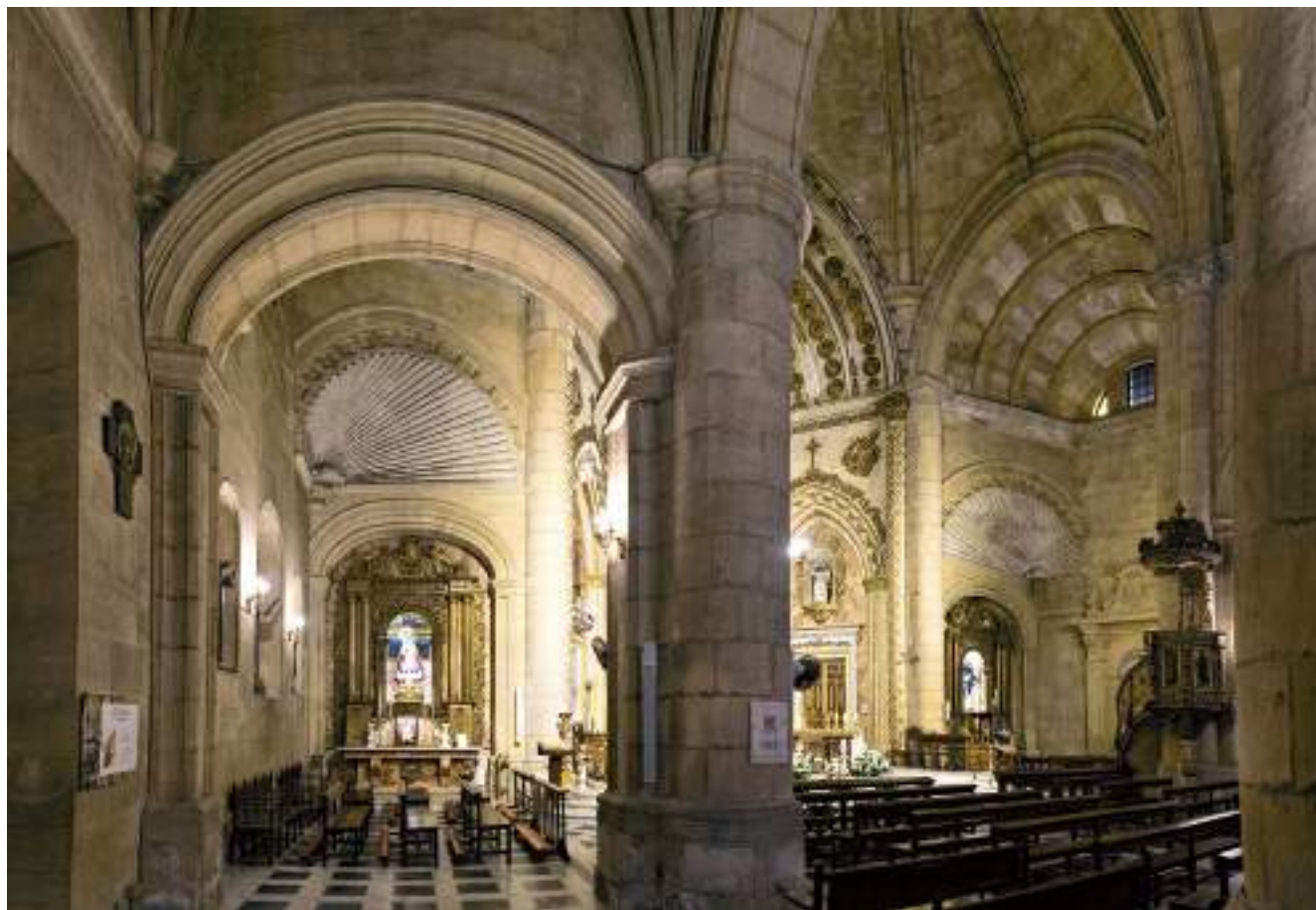
Perspectiva de la nave lateral y el crucero de la iglesia
