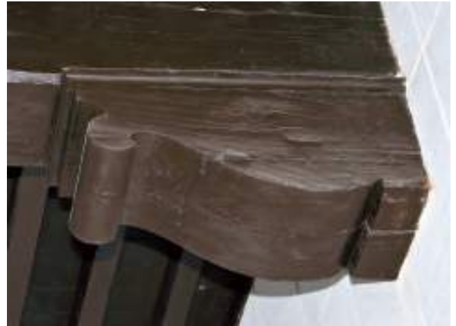
Ménsula de la armadura de la biblioteca
