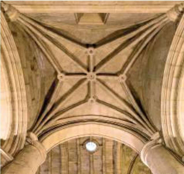
Bóveda de terceletes, característica del gótico tardío, cubriendo un tramo de una nave lateral
