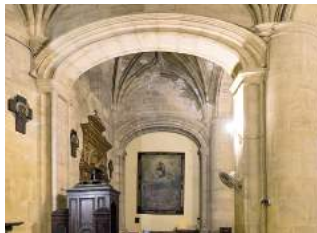
Nave lateral de la iglesia y detalle de las bóvedas
