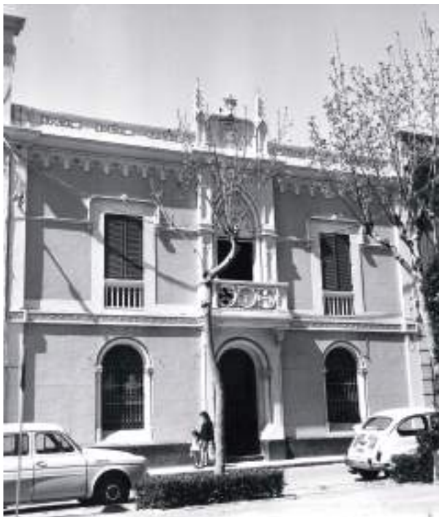
Fachada del antiguo convento en calle Conde Ofaía 28, antes de su demolición
