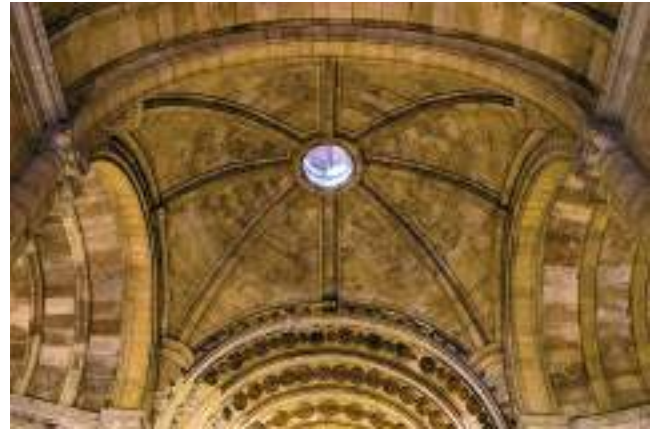
Bóveda del crucero
