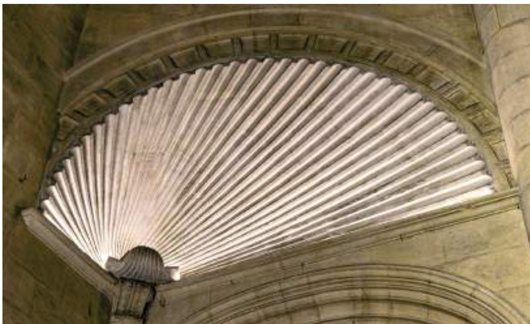
Detalle de una trompa de la cubierta de la iglesia de la Virgen del Mar en la actualidad
